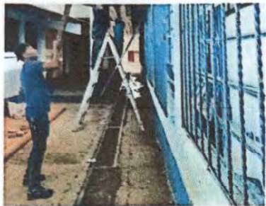
Foto 7: Reparación de balcones del módulo 2
