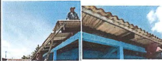
Foto 2: Sustitución de reglas de aula 1 y 2 del módulo 1
