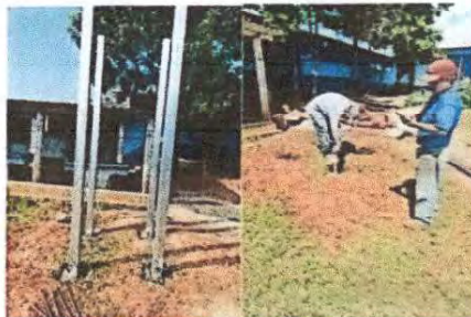
Foto 10: Reparación de malla a servicios de agua potable
