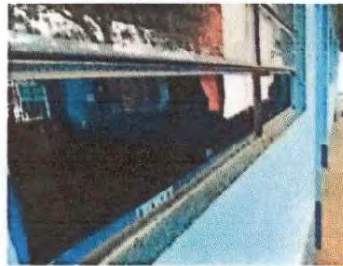
Foto 6: Sustitución de vidrios de ventanales
