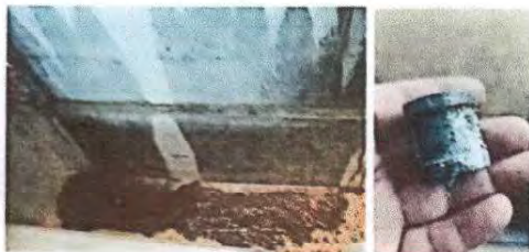
Foto 13: Sustrucción de llaves y tubo en meninorio
