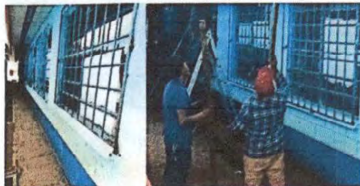
Foto 8: Reparación de balcones y cambio de vidrios de ventanales del módulo 2
