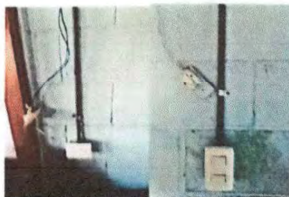
Foto 18: Sustrucción de cableado y tomacorrientes en aulas del módulo 1
