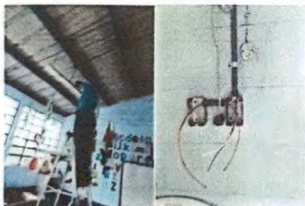
Foto 15: Sustrucción de lámparas en en interiores de las 3 aulas del módulo 1, 2 y 3.
