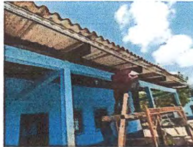
Foto 4: Sustitución de lámina de corredor del módulo 1.
