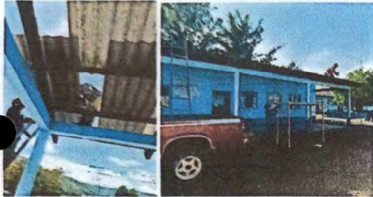
Foto 1: Sustitución lámina del interior del aula 1 y 2 del módulo 1
