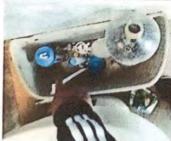
Foto 11: Sustitución de accesorios de inodoro de batería de baños de niñas.
