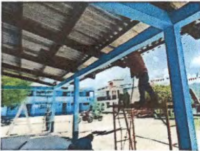
Foto 3: Sustitución de lámina del corredor del módulo 1
